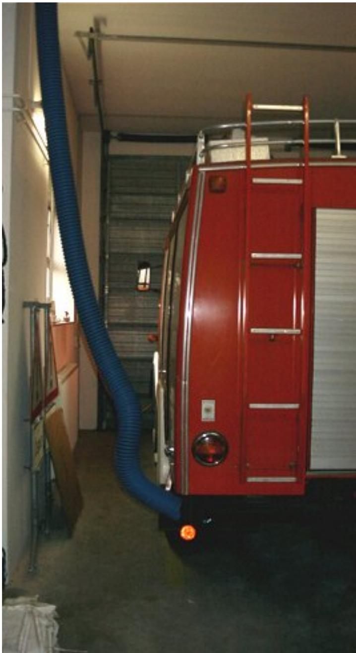
Durch diese Abgasabsauganlage verbessert sich die Luft in der Fahrzeughalle, in der auch die Einsatzkleidung der Kameraden offen hängt, während des Anlassens der Dieselmotoren der Fahrzeuge deutlich.
